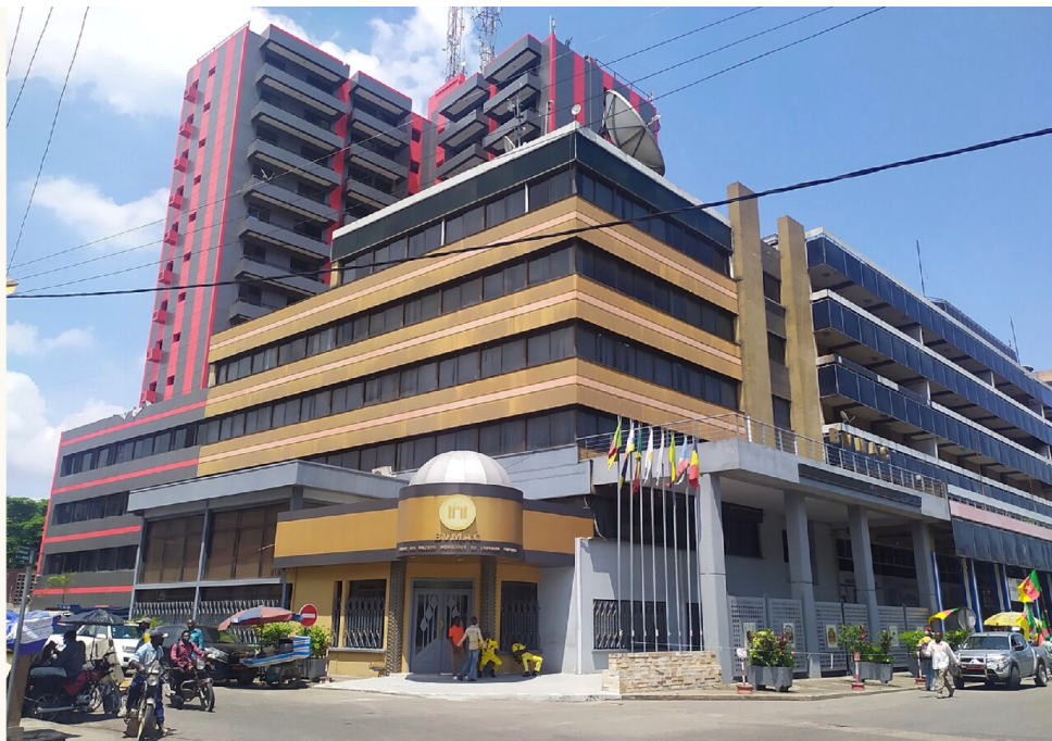
Le siège de la BVMAC à Douala. Photographie fournie, non retouchée.
